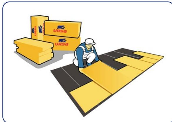
Desky pokládáme na suchý a čistý povrch hydroizolačního souvrství. Desky vedle sebe klademe s přesahem cca o polovinu délky.
