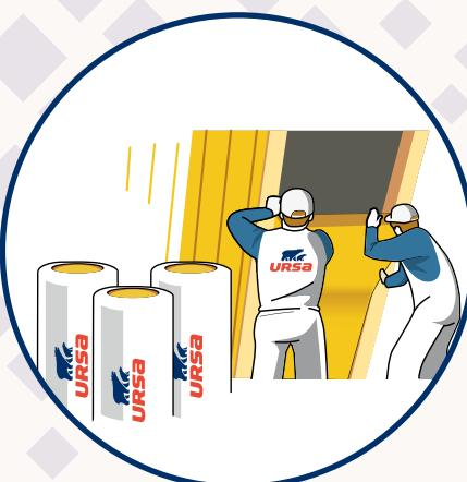
Aplikace minerální izolace URSA DF 35H mezi krovky. Izolaci mezi krovky postupně vkládáme lehkým vtláčením po obou stranách její výšky, až zaplníme celé krovkové pole. K zajištění izolace v krovkovém poli při aplikaci použijte fixační prvky např. drátkování.
