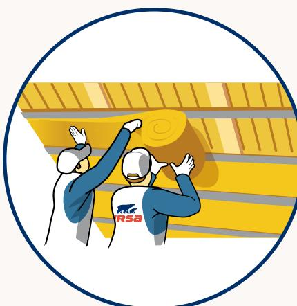
Aplikace minerální izolace URSA DF 35H do příčného kovového roštu upevněného na krovky, jako druhá tepelně izolační vrstva. Izolaci vkládáme lehkým vtláčením po celé délce roštu. Dbejte stejných zásad jako v předešlém aplikačním kroku.
