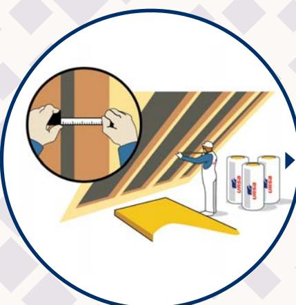
Změříme si šířku rozteče krovkí. Pro zajištění lepší fixace minerální izolace URSA DF 35H mezi krovkami přidáme k naměřenému rozmezru ještě 1,5–2 cm.
