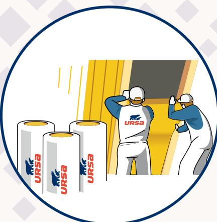
Aplikace minerální izolace URSA DF 32H mezi krovky. Izolaci mezi krovky postupně vkládáme lehkým vtláčením po obou stranách její výšky, až zaplníme celé krovkové pole. K zajištění izolace v krovkovém poli při aplikaci použijte fixační prvky např. drátkování.
