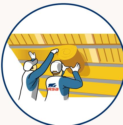
Aplikace minerální izolace URSA DF 32H do příčného kovového roštu upevněného na krovky, jako druhá tepelně izolační vrstva. Izolaci vkládáme lehkým vtláčením po celé délce roštu. Dbejte stejných zásad jako v předešlém aplikačním kroku.
