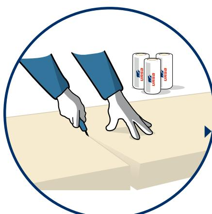
Odrezeme nameranú časť minerálnej izolácie URSA PUREONE SF 34. Rez vykonávame pozdiž prítlačnej lišty (časť OSB dosky, kovový profil a pod.) špeciálnym nožom URSA určeným na rezanie izolácie.
