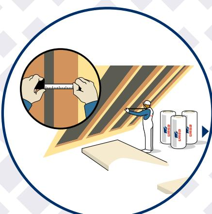
Zmeriame si potrebnú šírku izolácie medzi krovkami. Pre zabezpečenie lepšej fixácie minerálnej izolácie URSA PUREONE SF 34 medzi krovkami pridáme k nameranému rozmeru ešte 1 cm. Pre l'ahšie rezanie je minerálna izolácia URSA PUREONE SF 34 priečne potlačená ryskami (rozteč tlačených rysiek je a 10 cm).
