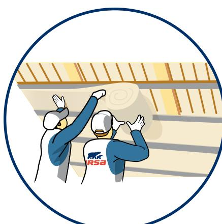
Aplikácia minerálnej izolácie URSA PUREONE SF 34 do priečneho kovového roštu upevneného na krovky, ako druhá tepelnoizolačná vrstva. Izoláciu vkladáme ľahkým vtlačením po celej dĺžke roštu. Dbajte rovnakých zásad ako v predošlom aplikačnom kroku.
