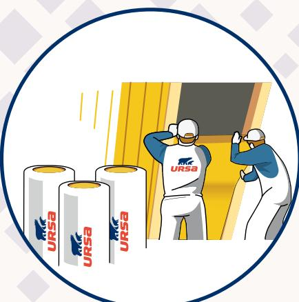
Aplikace minerální izolace URSA SF 32 PLUS mezi krovky. Izolaci mezi krovky postupně vkládáme lehkým vtlačením po obou stranách její výšky, až zaplníme celé krovkové pole. K zajištění izolace v krovkovém poli při aplikaci použijte fixační prvky např. drátkování.
