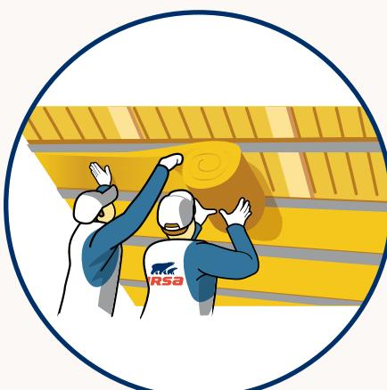
Aplikace minerální izolace URSA SF 32 PLUS do příčného kovového roštu upevněného na krovky, jako druhá tepelně izolační vrstva. Izolaci vkládáme lehkým vtlačením po celé délce roštu. Dbejte stejných zásad jako v předešlém aplikačním kroku.
