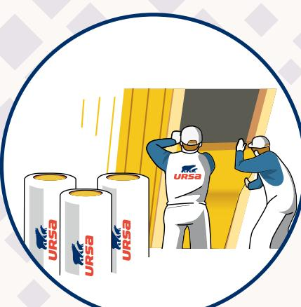
Aplikace minerální izolace URSA USF 35 PLUS mezi krovky. Izolaci mezi krovky postupně vkládáme lehkým vtlačením po obou stranách její výšky, až zaplníme celé krovkové pole. K zajištění izolace v krovkovém poli při aplikaci použijte fixační prvky např. drátkování.
