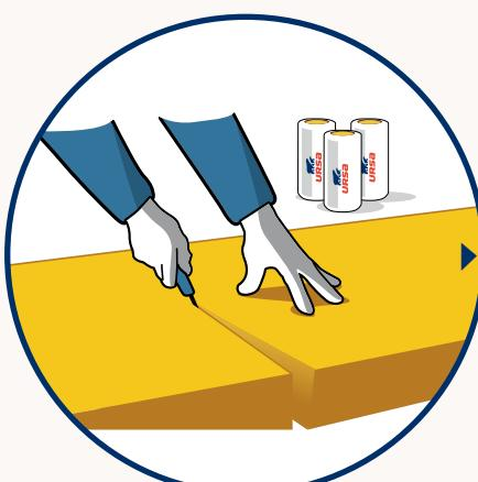
Odřízneme naměřenou část minerální izolace URSA USF 35 PLUS. Řez provádime podél přítlačné lišty (část OSB desky, kovový profil apod.) speciálním nožem URSA určeným k rezání izolace.
