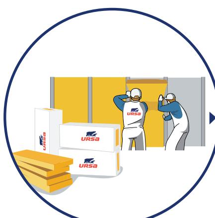
Aplikace minerální izolace URSA PUREONE TWP 37 do připraveného rostu sádrokartonového systému. Izolaci do rostu vkládáme lehkým vtlačením po celé její výšce. Dutina rostu musí být vyplňena izolací po celé své výšce.
